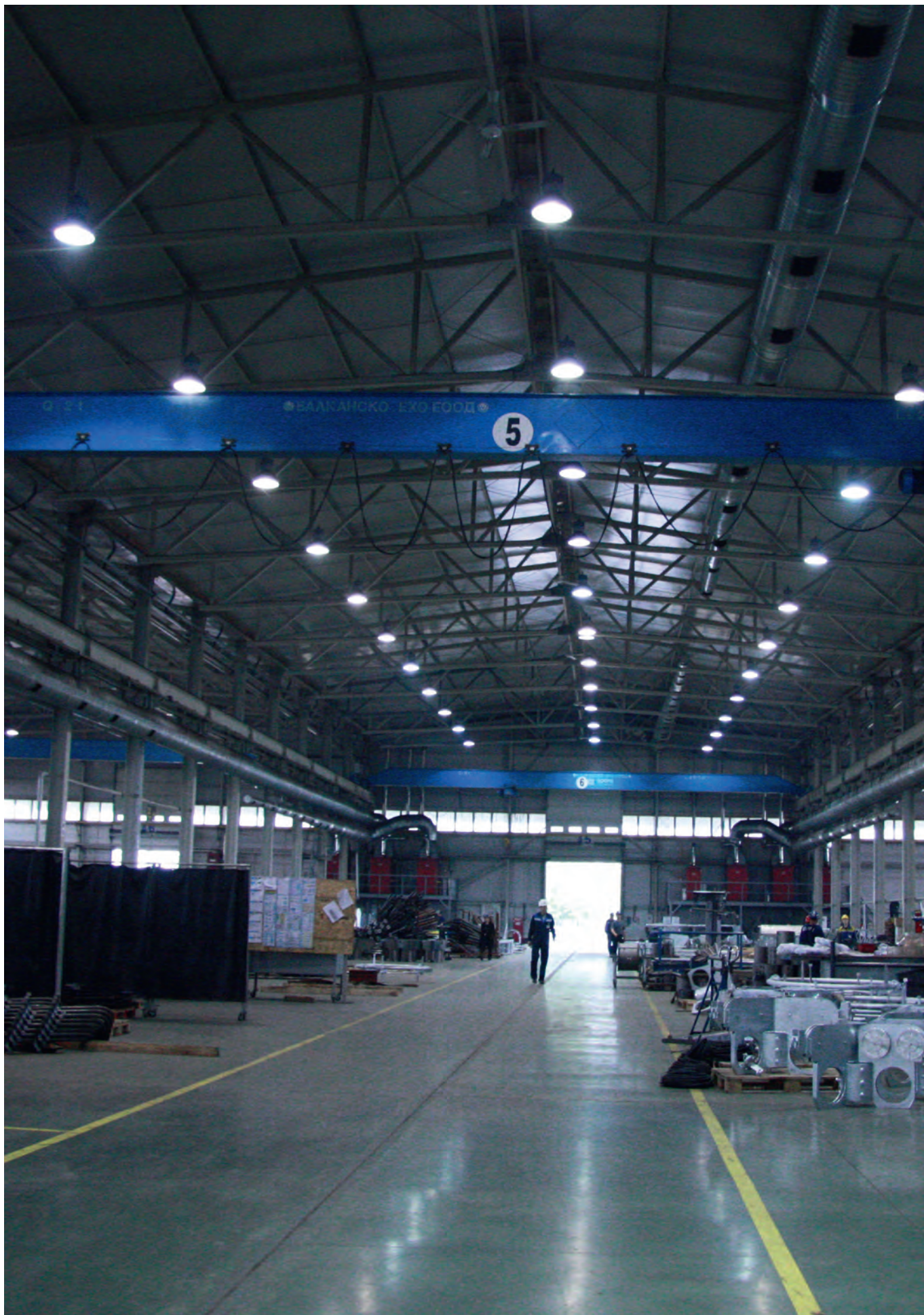
г. Тула, завод Опора Инжиниринг
