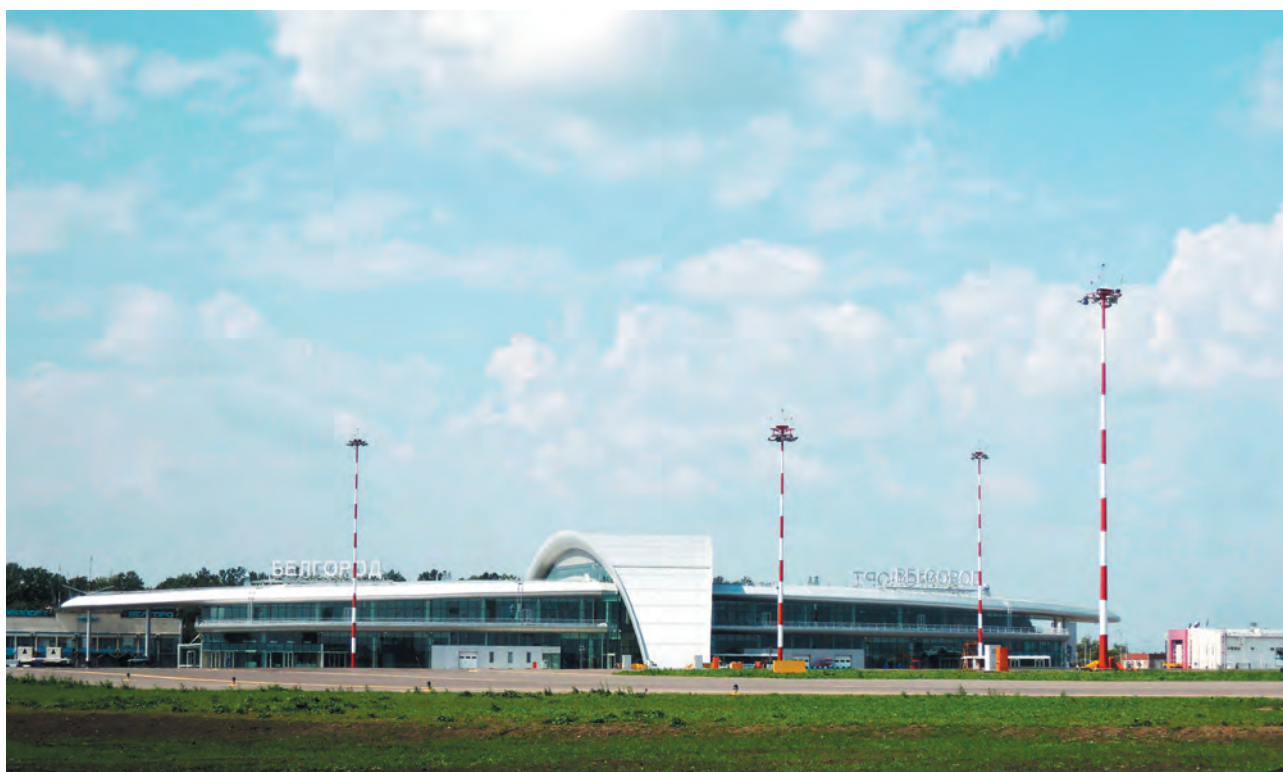
Функциональное освещение перронов аэропорта Белгород. Мачты специальные с дневной маркировкой с рабочими и аварийными прожекторами и огнями ЗОМ.
